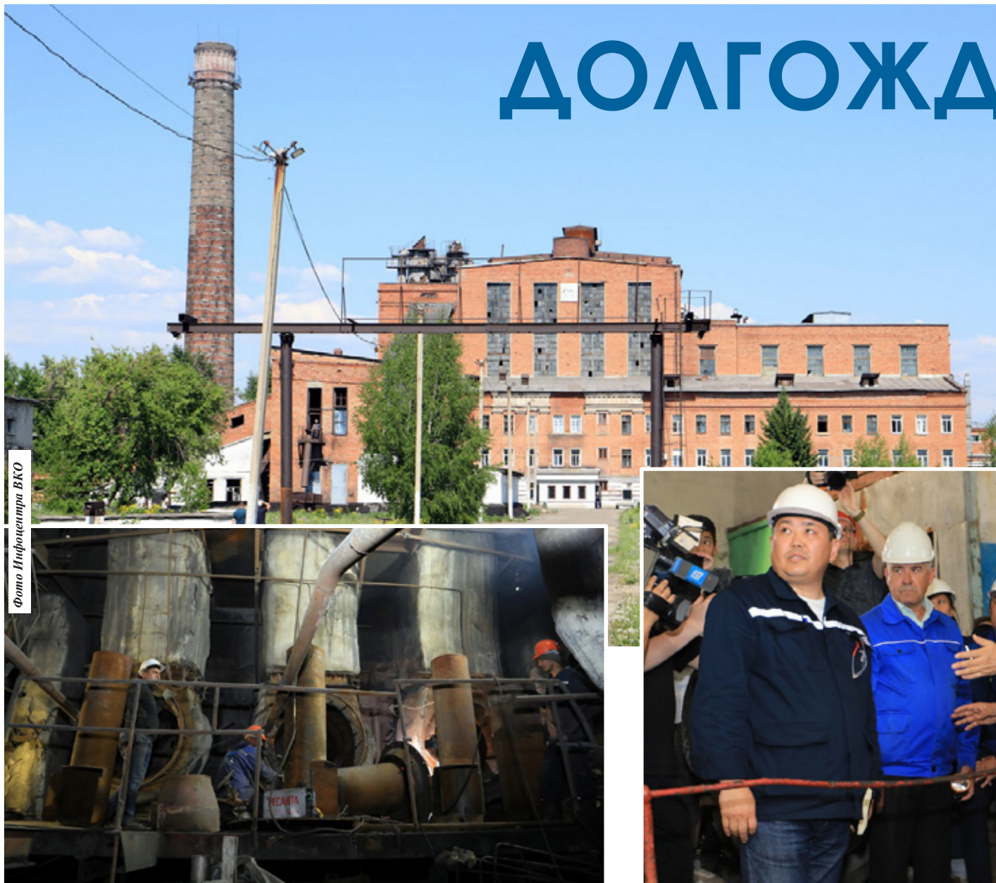
Ремонтные работы уже ведутся на всех 6 котлах станции
