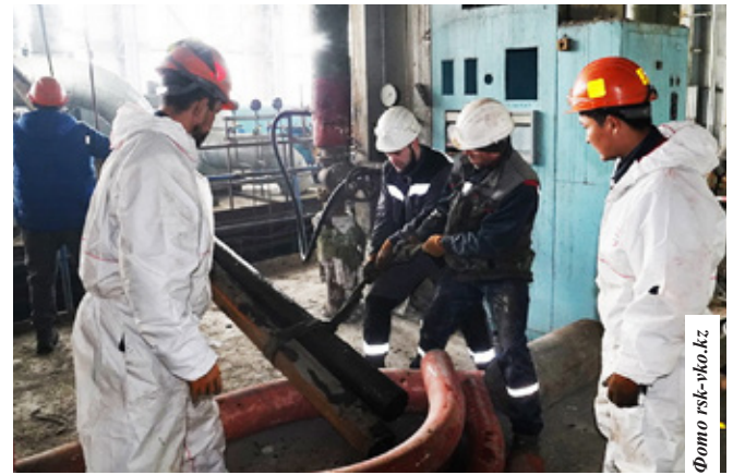
Ремонтные работы на Риддер ТЭЦ близятся к завершению
